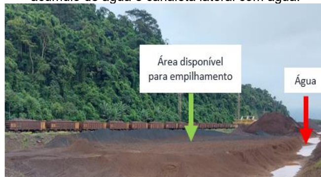
Figura 01 - Fotografias da base de granulado apresentado a área disponível para empilhamento sem acúmulo de água e canaleta lateral com água.
