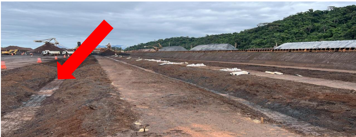
Figura 10 – Cava da drenagem forçada
