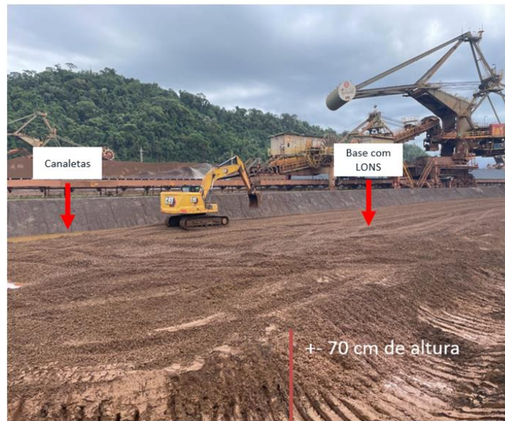
Figura 24 - Alçamento com granulado.
