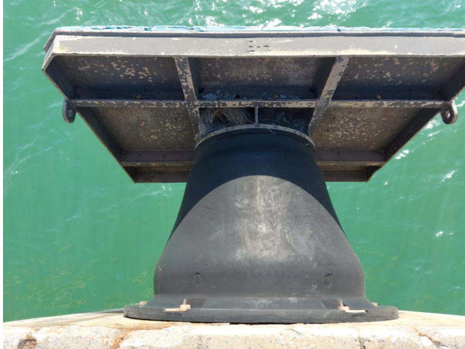
Figura 87 – Elastômero com marcação do parafuso de fixação no paramento devido a uma possível compressão operacional excessiva
