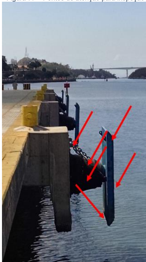
Figura 77 – Pontos de atenção para inspeção
