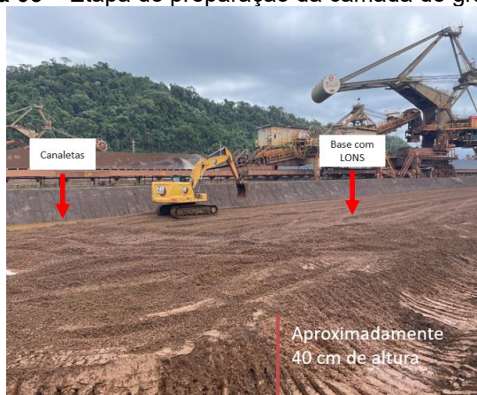
Figura 03 – Etapa de preparação da camada de granulado.
