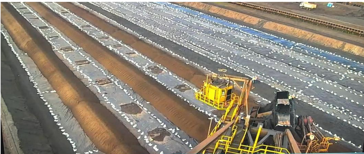
Figura 12 – Material permeável sendo aplicado nas cavas
