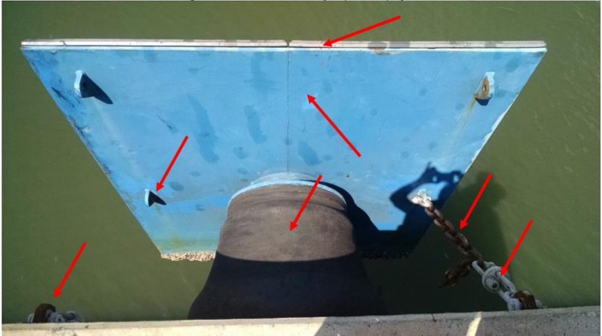
Figura 78 – Pontos de atenção para inspeção
