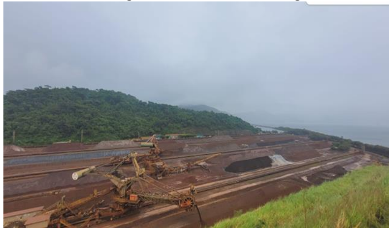
Figura 4 - Pátio de Estocagem.
