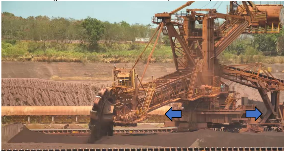
Figura 102 - Movimento de Translação da Recuperadora
