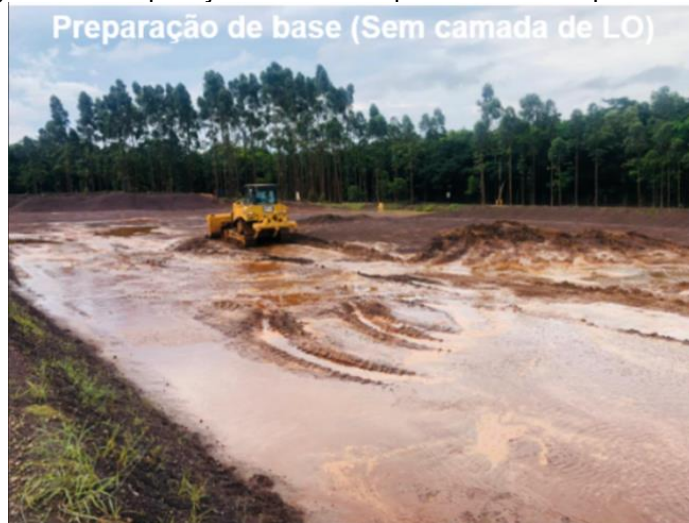
Figura 07 - Preparação de área em períodos de alta pluviometria.
