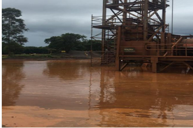
Figura 18 - Sistema de drenagem ineficiente.
