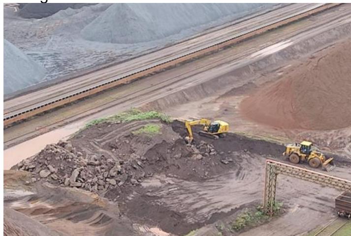
Figura 21 - Área com material contaminado.
